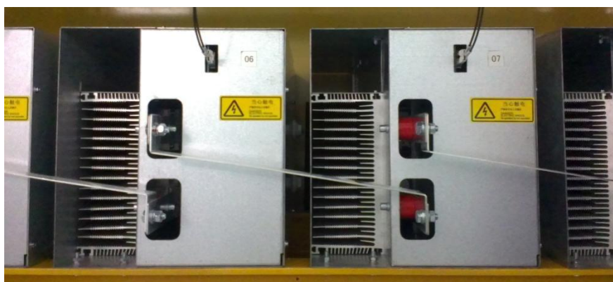
图 5-5 链式静止无功发生器功率模块
